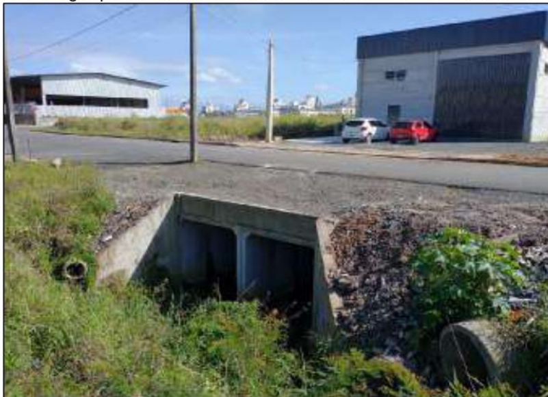
Figura 13 – Curso d'água passa em início de trecho tubulado na Rua Júlio de Castilho.
