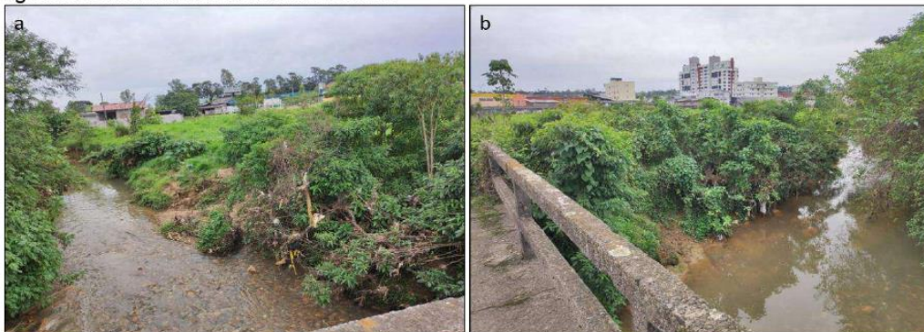
Figura 78 - Local aonde ocorre inundações frequentes com resíduos presos nos galhos das arvores e margens erodidas no Bairro Santa Barbara.
