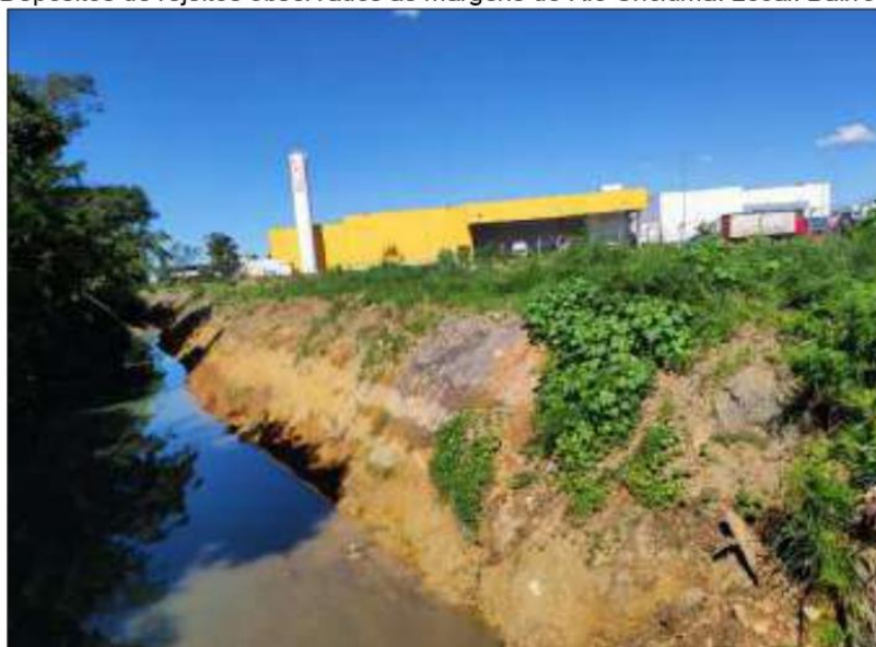
Figura 65 – Depósitos de rejeitos observados as margens do Rio Criciúma. Local: Bairro Pinheirinho.
