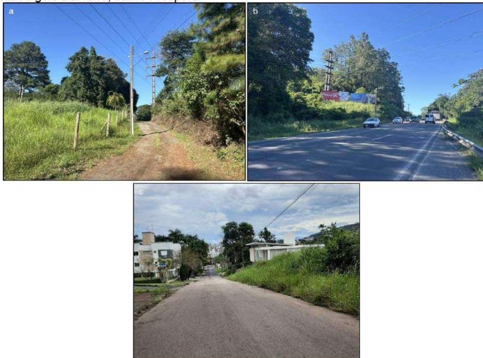
Figura 132 - Trechos da linha de transmissão incidentes na área de estudo. a) R. Mil Quatrocentos e Trinta e Quatro, bairro Mina Brasil; b) Rod. SC-180 próximo à Rua Paulino Bussolo, bairro Mina Brasil e c) Rua Ângelo Dal farra, bairro Próspera.
