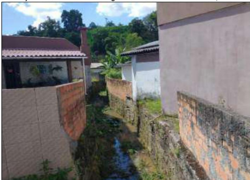
Figura 139 - Edificações situadas sobre a margem de afluentes do rio Criciúma, bairro Vera Cruz.
