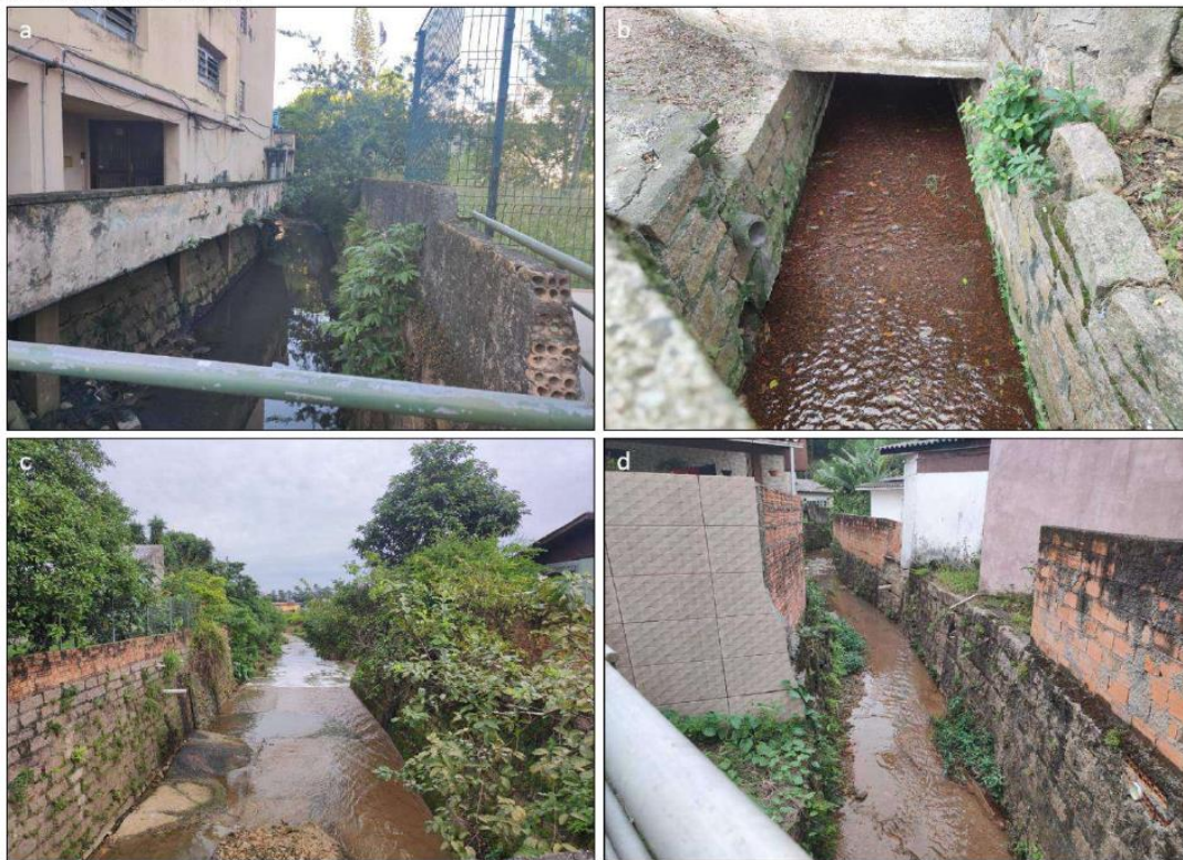
Figura 85 – Trechos em que o curso d'água está canalizado com as margens revestidas por muros de pedra e concreto a) Bairro Centro, próximo ao Supermercado Angeloni b) Bairro Santo Antônio, na Rua Maria Fernandes Argente c) Bairro Santa Barbara, na Rua Vicente Nunes Barcelos d) Bairro Vera Cruz, na Rua João Pessoa.
