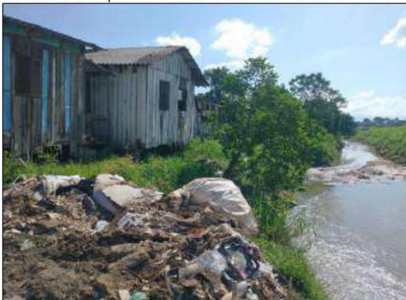
Figura 124 - Moradias de baixo padrão construtivo em APP do rio Criciúma.
