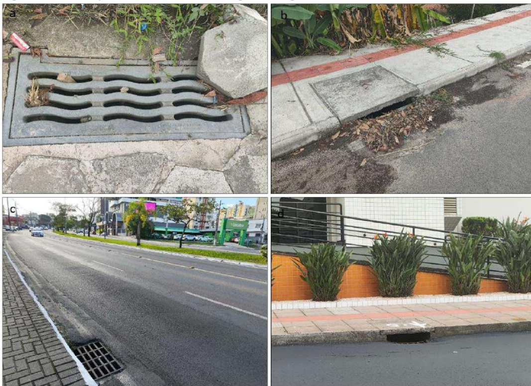
Figura 135 - Exemplos de elemento de drenagem averiguados
