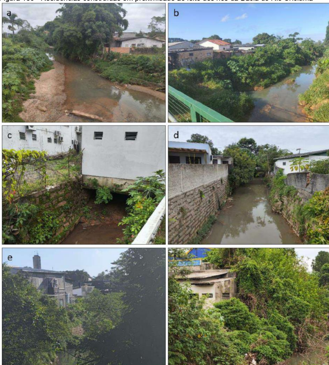
Figura 136 - Residências construídas em proximidade ao leito dos rios da Bacia do Rio Criciúma
