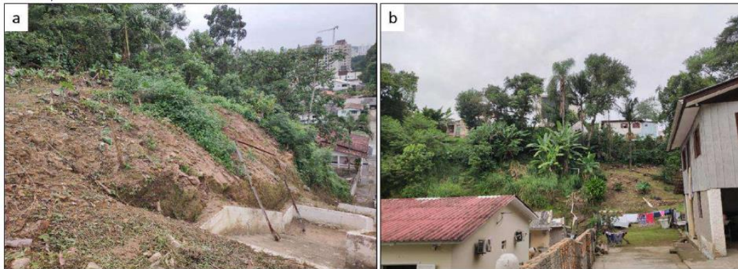
Figura 83 - Vista de um local potencialmente favorável a ocorrência de processos de movimentação de massa, no Bairro Santa Catarina.
