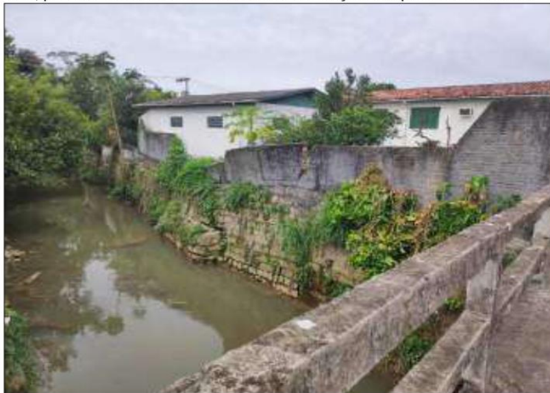
Figura 86 – Trecho em que o curso d'água está canalizado com as margens revestidas por muros de pedra e concreto, porém está desmoronando devido a atuação dos processos fluviais.
